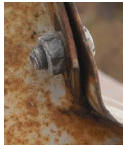
Рис. 6. Послаблення болтового з'єднання.
