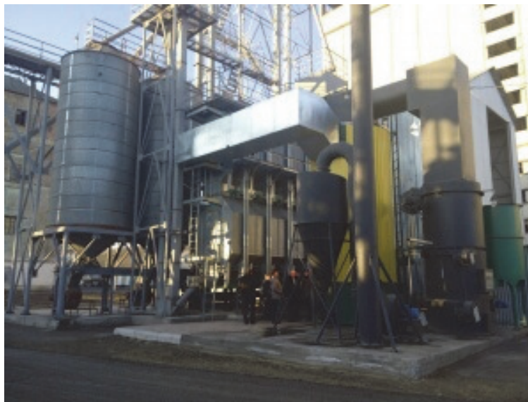
Рис. 1. Комплекс на базі зерносушарки Sukup і біотеплогенератора
