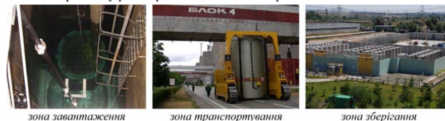
Рис. 2. Технологічні зони системи сухого зберігання ВЯП
