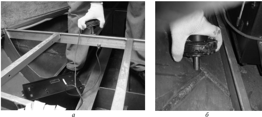
Рис. 6. Электродинамическая обработка сварных ремонтных швов корпуса судового корпуса
