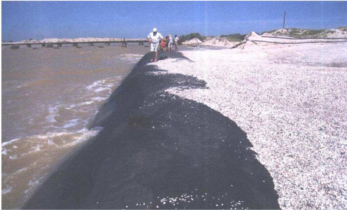
Рис. 5. Крепление берега наполняемыми грунтом оболочками Fig. 5. Fixing the coast is filled with ground shells
