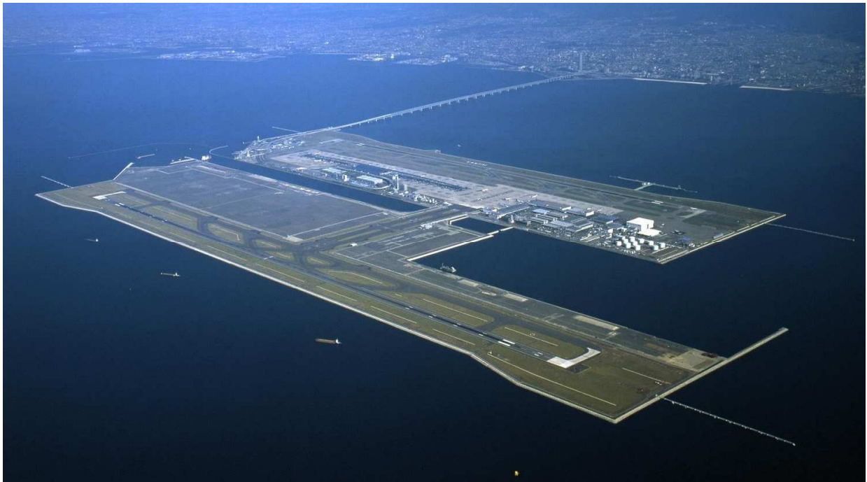
Рис. 1. Аеропорт Кансай Fig. 1. Kansai Airport
