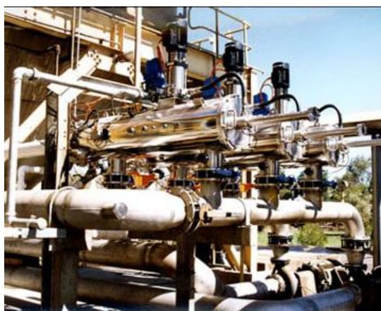
Рис. 3. Батарея фильтров Filtomat MCFM 306 XLP на картонно-бумажной фабрике Fig. 3. Filters Battery Filtomat MCFM 306 XLP on cardboard and paper mill
