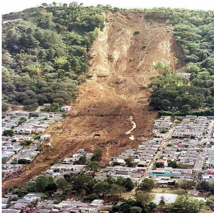
Rys.2. Osuwisko w San Salvador 2001 r. [21]
