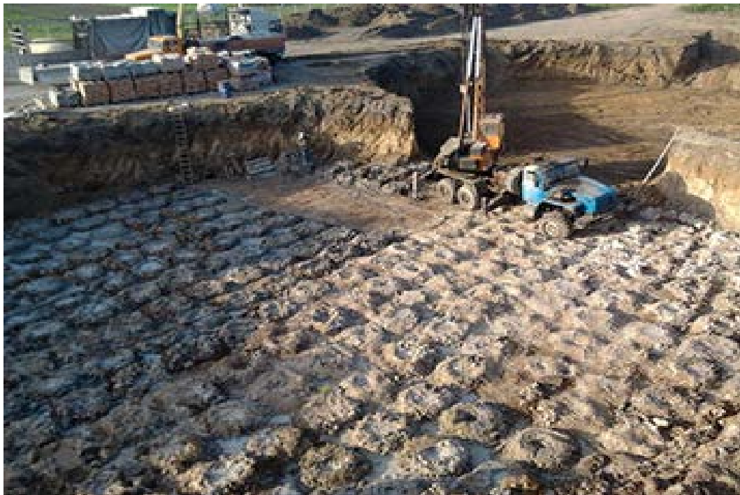
Рис. 13. Загальний вигляд штучної основи з вертикальних ГЦЕ Fig. 13. General view of artificial base from of vertical cementitious elements
