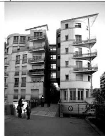
Рис 3. Жилое здание в составе квартала в г. Париж.
