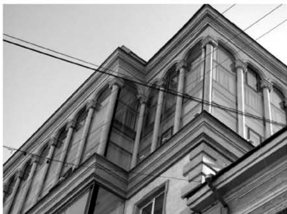
Рис. 1. Новое здание по улице Греческой, 31
