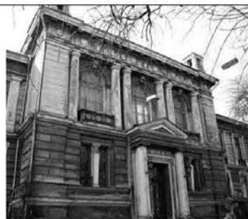
Рис. 3. Вход в здание Анатомического института со стороны Валиховского переулка, фото 2011 г.
