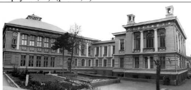
Рис. 2. Корпус Анатомического института со стороны двора, фото 50-х годов XX в.
