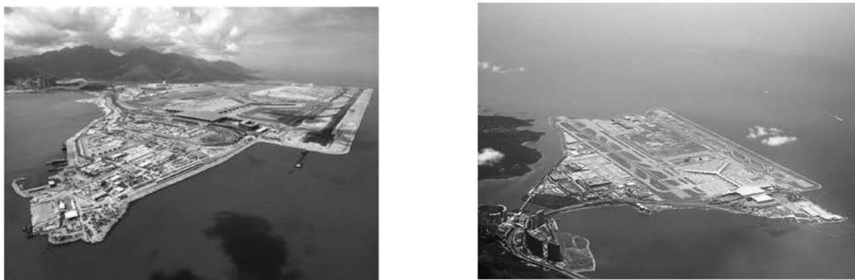
Рис. 8. Общий вид аэропорта Чхеклапкок (Гонконг)
