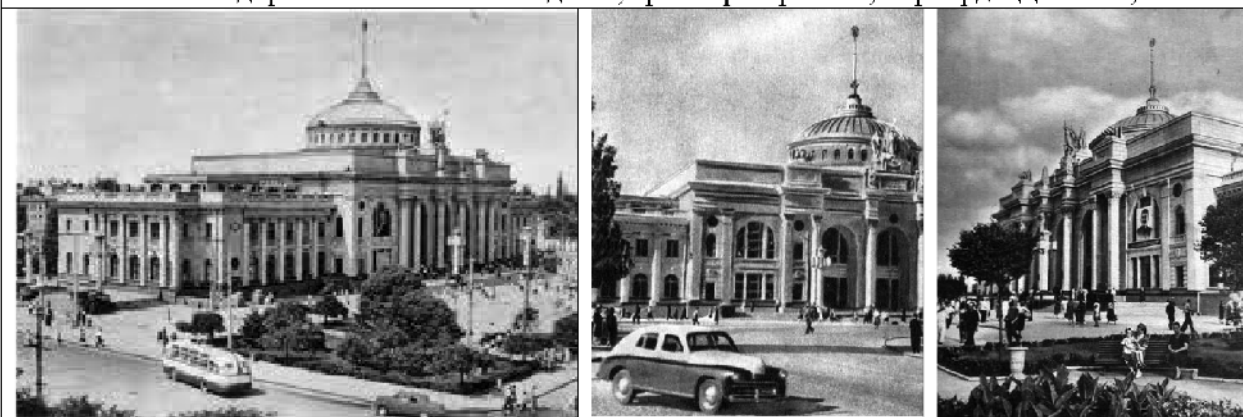
Рис. 1б. Железнодорожный вокзал в г. Одесса, арх. Чуприн Л. М., «Киевтрансюзелпроект», 1949–1952 гг. Фото 1950-х годов
