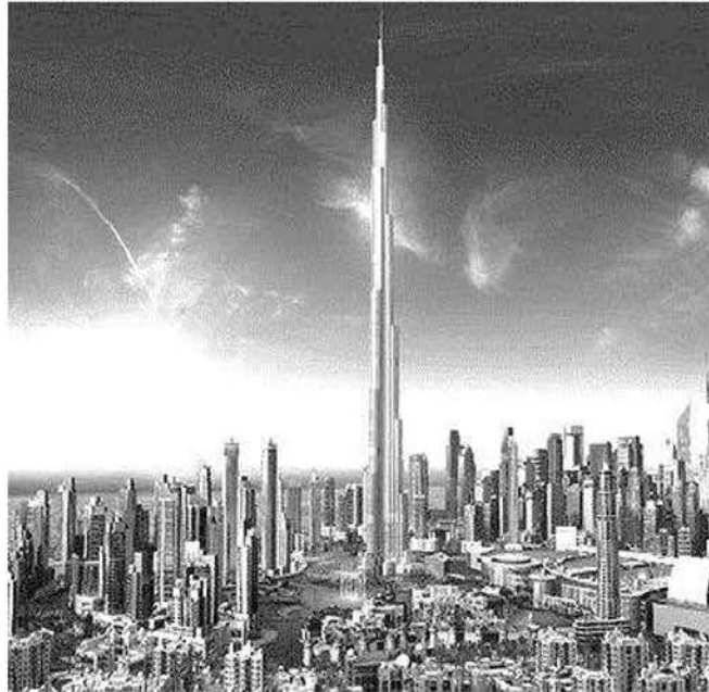
Рис. 3. Небоскребы Дубая (ОАЭ) с зеркальным остеклением фасадов
