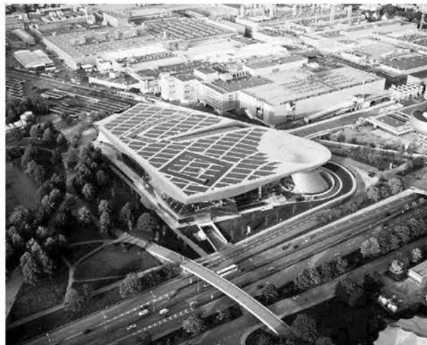
Рис. 7. Центр BMW в Мюнхене (Германия) – в кровлю вмонтированы солнечные батареи
