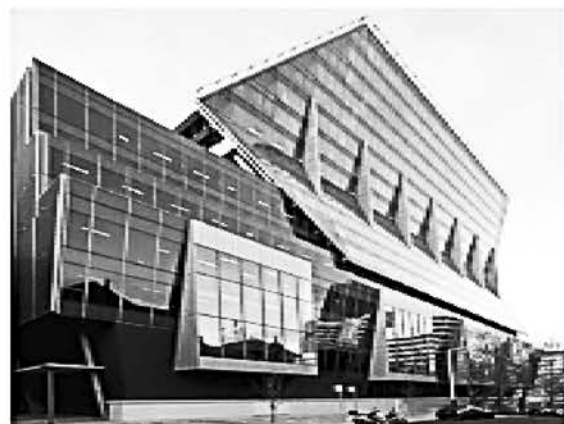
Рис. 9. ArkBuilding в Сиднее (Австралия) – в фасад вмонтированы солнечные батареи
