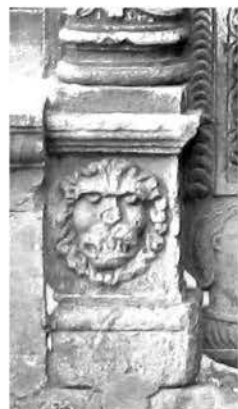
рис. 5в. Пошкоджені маскарони левів на базах півколонок порталу каплиці
