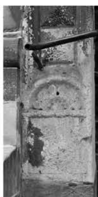
Рис. 3в. Пошкоджені деталі південного portalу
