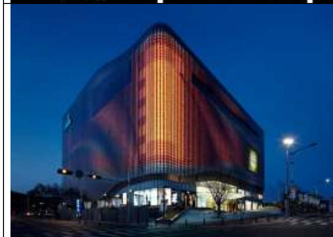
Рис. 2. Galleria Centercity – медиа-фасад с эффектом оптической иллюзии. Архитектор Бен ван Беркель компании UNStudio. Реализация – Южная Корея, 2011 год. Оптический эффект фасада заключается в образовании объемных муаровых узоров. В ночное время здание оживает мириадами огней и красок благодаря сложной системе подсветки и генерируемой компьютером анимации, отображающейся на фасаде
