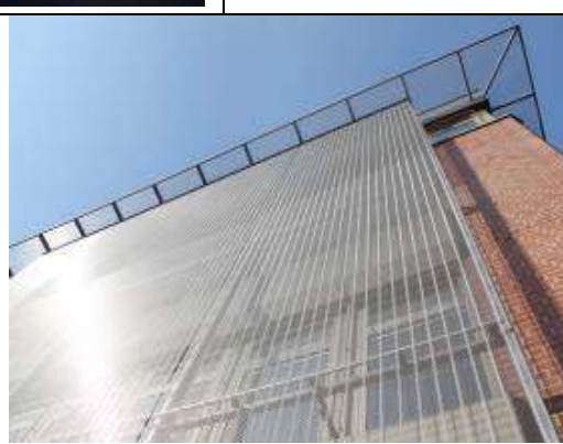
Рис. 2. Galleria Centercity – медиа-фасад с эффектом оптической иллюзии. Архитектор Бен ван Беркель компании UNStudio. Реализация – Южная Корея, 2011 год. Оптический эффект фасада заключается в образовании объемных муаровых узоров. В ночное время здание оживает мириадами огней и красок благодаря сложной системе подсветки и генерируемой компьютером анимации, отображающейся на фасаде
