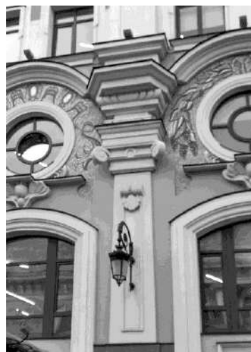
Рис. 3. Детали фасада здания на Бунина, 10
