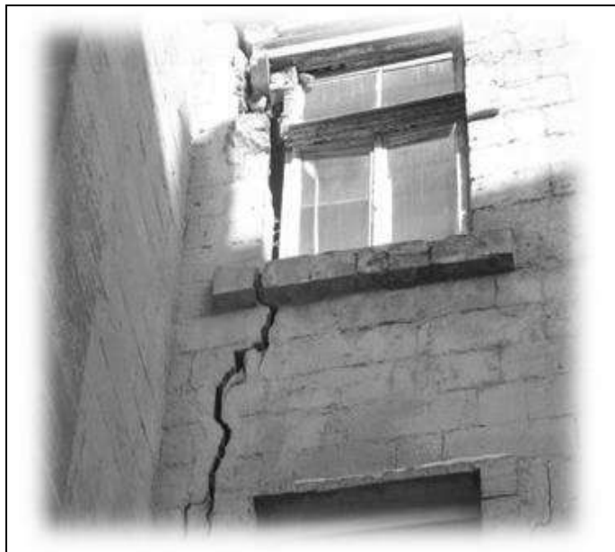
Рис. 1. Жилой дом, ул. Градоначальницкая, №1, Одесса.
