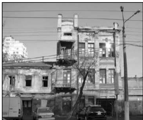
Рис. 7. Жилое здание, Одесса (снесено в 2011 г.)
