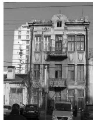
Рис. 9. Жилое здание, Одесса (снесено в 2011 г.)
