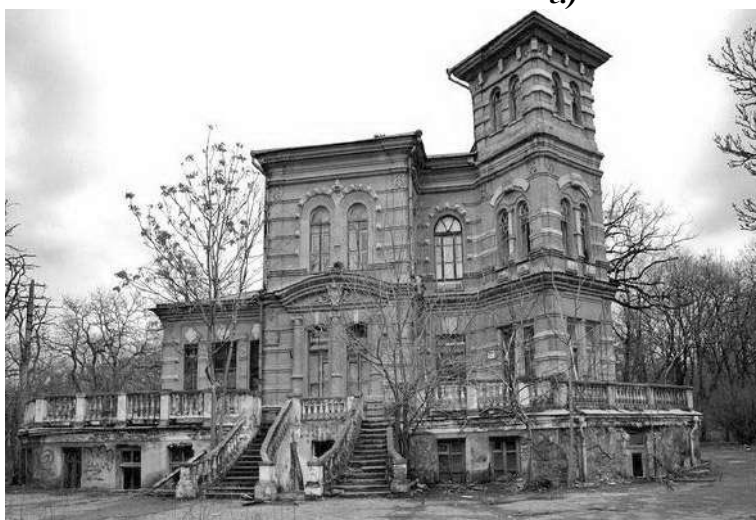
Рис. 11. Здание санатория «Дружба» (снесено 2016 г.), Одесса
