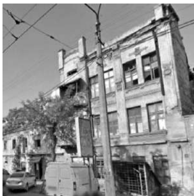
Рис. 8. Жилое здание, Одесса
