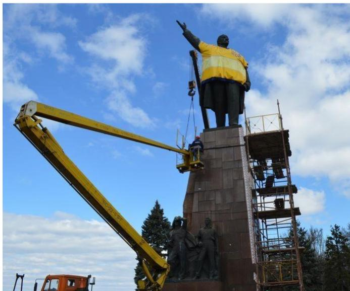
Рис. 8. Установка площадки для работ по спилу
