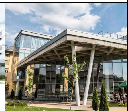
Рис. 13. Фрагмент входа многофункционального здания
