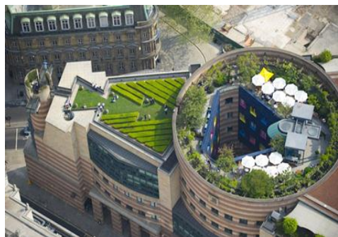
Рис. 1. Сад на кровле
