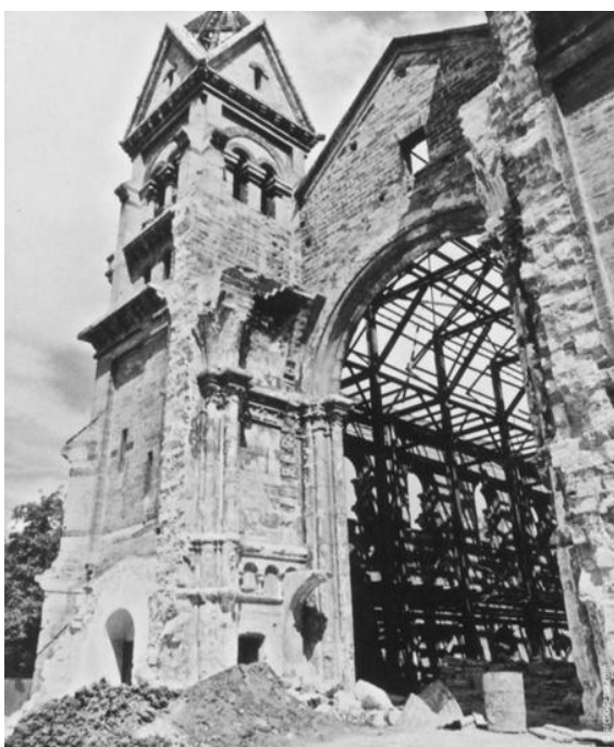
Рис.5 Залишки будівлі і несучих конструкцій Кірхи перед реконструкцією
