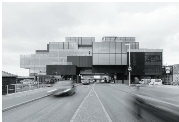
Рис. 3. Здание BLOX, Копенгаген
