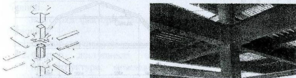
Рис. 5. Рамний вузол металевого каркаса нового корпусу вокзалу:
