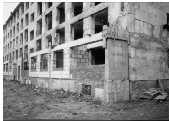
Рисунок 3 — Начало монтажа пилонов уширения здания по ул. Парковая, 756
