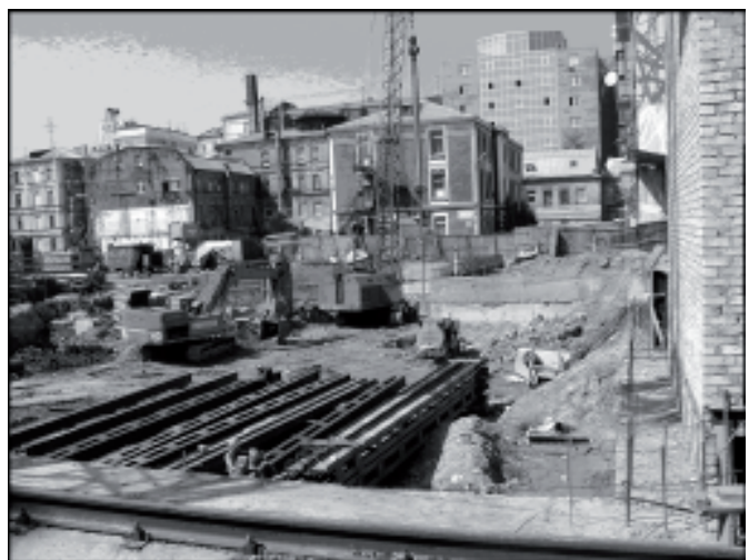
Рисунок 3. Встановлення паль в котловані біля існуючих будинків
