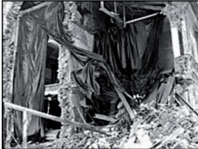
Рисунок 4. Наслідок пожежі в горищному приміщенні
