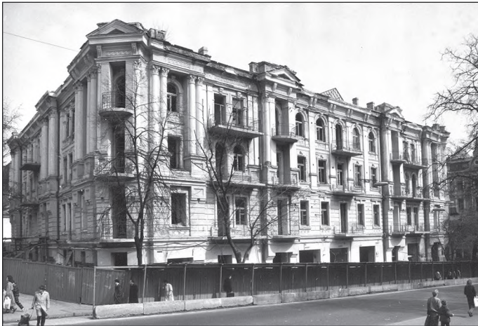
Рисунок 5. Відселений перед капітальним ремонтом будинок. Фото 1990 р.
