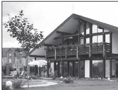
Рисунок 1. Здание, оборудованное системой солнечного теплоснабжения
