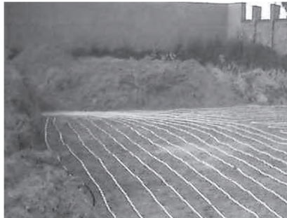
Рисунок 4. Фрагмент укладки грунтового коллектора
