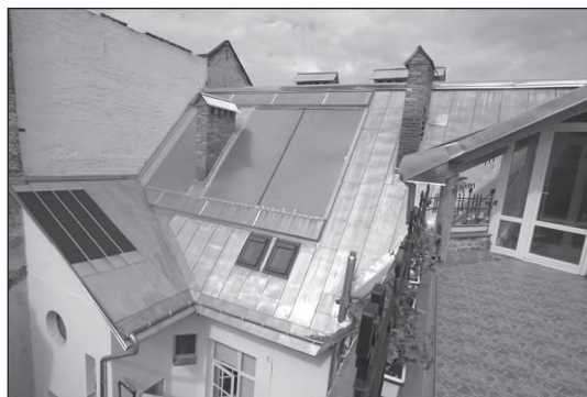
Рисунок 1. Реконструированная крыша здания в г. Львове
