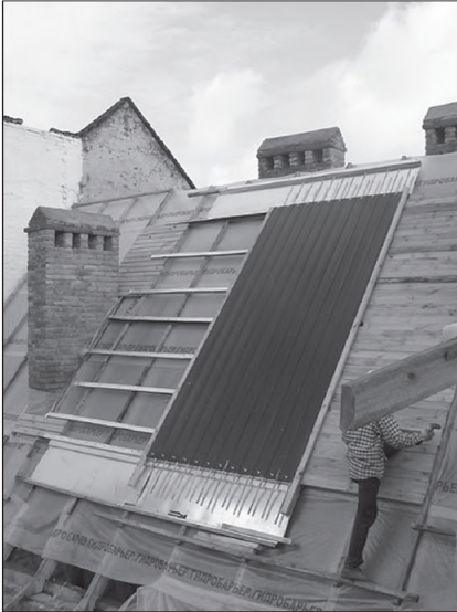
Рисунок 2. Монтаж на новый каркас крыши
