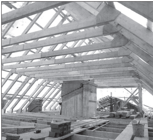
Рисунок 1. Несучі конструкції дерев'яних мансард. (Росія, м. Литкарино): а – система висячих крокв мансарди; б – загальний вигляд будівлі, що реконструюється, після надбудови мансарди; в – інтер'єр мансарди (під час будівництва).
