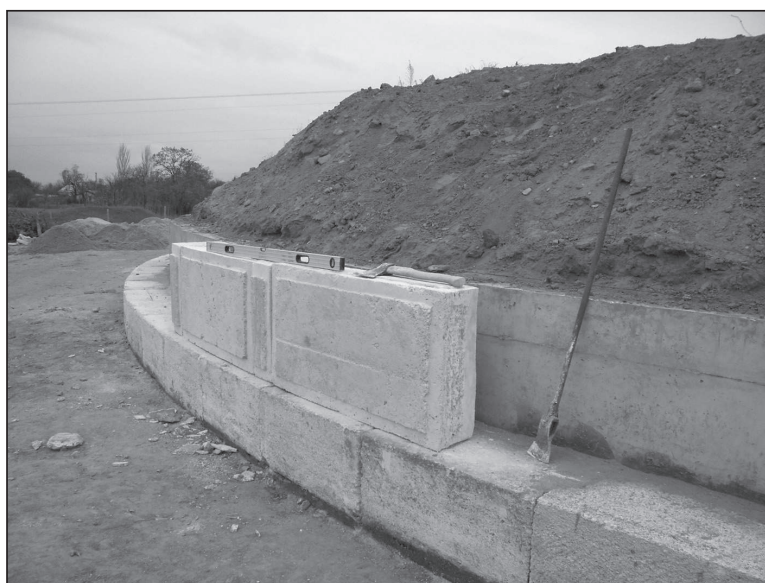
Рисунок 9. Прилаштування елементїв крєпїди на фундамент
