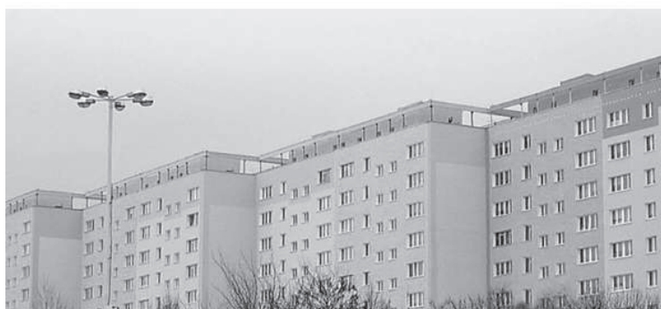
Рисунок 1. Вид зданий после термомодернизации
