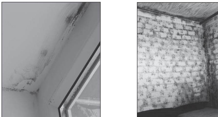
Рисунок 7. Стани теплових відмов на поверхні стін стелі житлового приміщення в перший холодний період після заміни вікон на сучасні ПВХ-вікна з однокамерним склопакетом 4М-16-4М (а) та зовнішньої стіни після проведення утеплення з боку внутрішньої поверхні (б)
