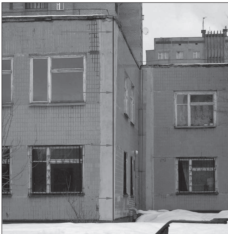
Рисунок 6. Отклонение стены детского сада по оси «А» от вертикали на 70 мм
