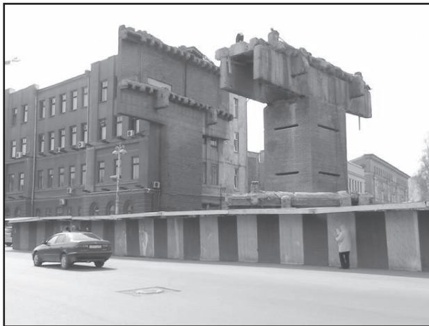
Рисунок 2. Завершение сноса дома
