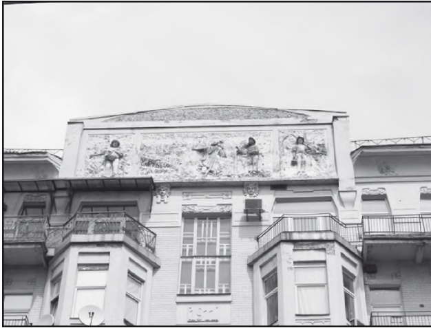
Рисунок 2. Фрагмент фасада, ул.Саксаганского. Июль 2010 г.
