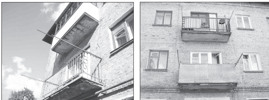
Рисунок 2. Фрагменти фасадів будинку з пошкодженими балконними плитами
