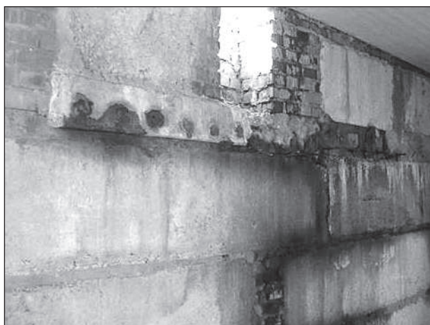
Рисунок 3. Вогкість, цвіль стін від затікання атмосферних опадів
