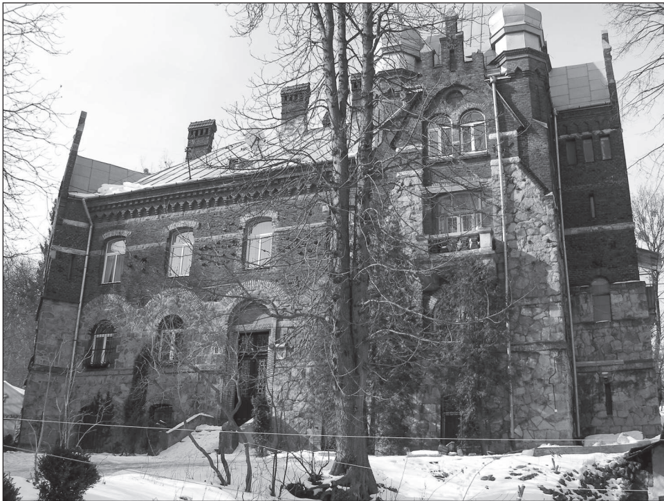
Рисунок 1. Загальний вигляд будинку, 2010 р.
