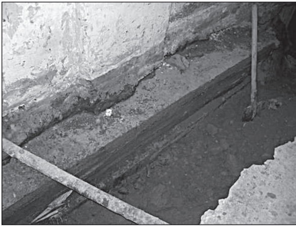
Рисунок 8. Кінцевий етап ліквідації аварійної ситуації. Забетонувана підшва бутового фундаменту разом з порожнинами центральної несучої стіни (а) та стіни центрального входу будинку (б)
