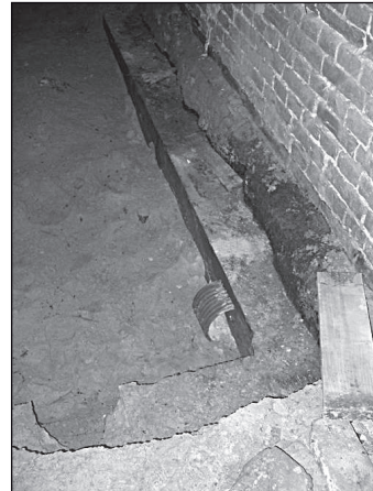
Рисунок 8. Кінцевий етап ліквідації аварійної ситуації. Забетонувана підшва бутового фундаменту разом з порожнинами центральної несучої стіни (а) та стіни центрального входу будинку (б)
