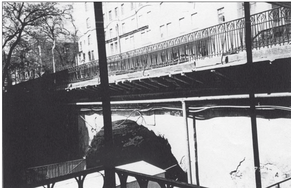
Рисунок 2. Вид Новикова моста с низовой стороны
