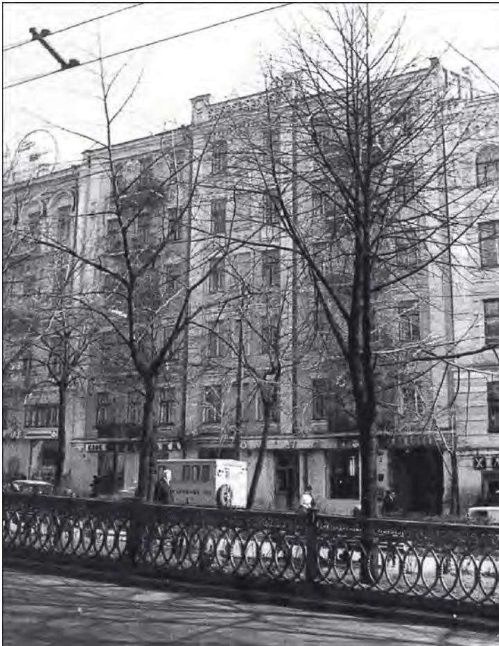
Рисунок 13. Фасад здания о начала ремонта, ул.Бассейная,3, 1975 г. [21]
