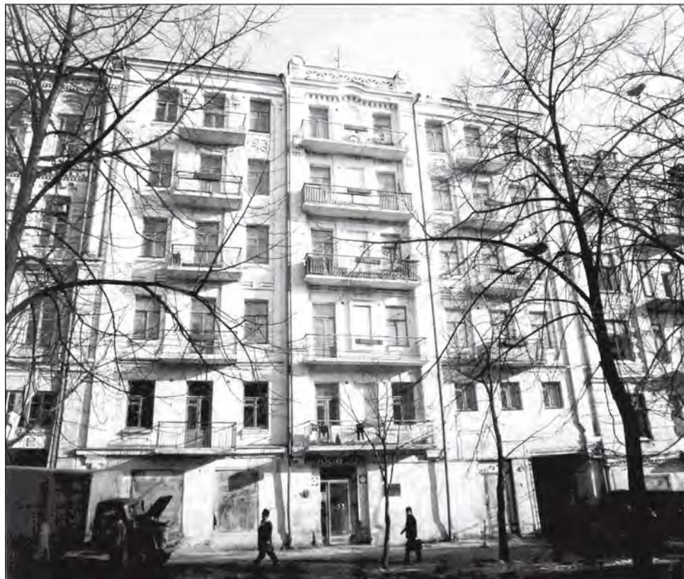
Рисунок 14. Фасад здания в процессе завершения строительных работ, ул.Бассейная,3, 1975 г. [21]
