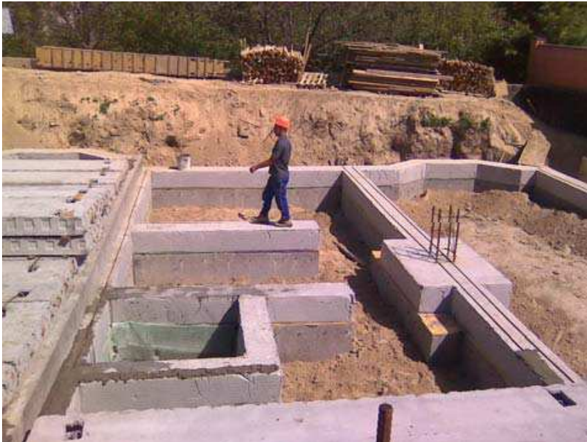
Рис. 2 Схема влаштування розподільчого поясу по віброізолюючих матах при точковій та відсічній ізоляції опор житлового будинку по вул. Вільшанській, Печерський район, м. Київ
