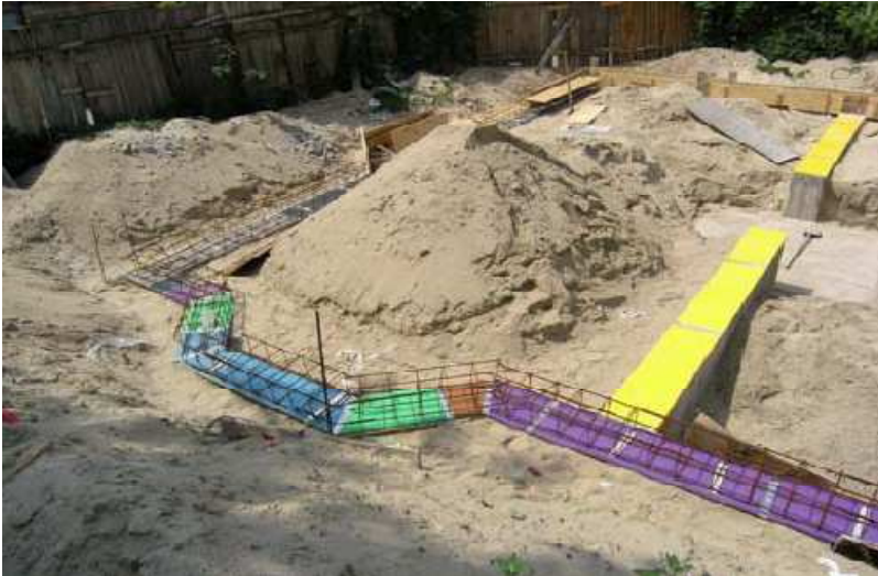
Рис. 1 Схема влаштування віброізолюючих матів фундаментів житлового будинку по вул. Звіринській, Печерський район, м. Київ
