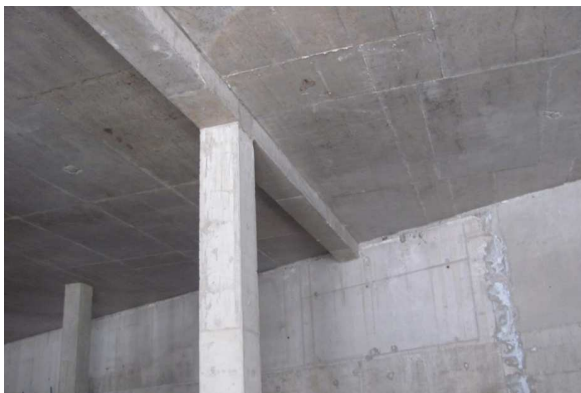
Рис. 3. Сопряжение колонн с перекрытиями посредством монолитных железобетонных ригелей.
