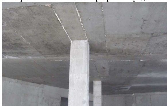
Рис. 4. Сопряжение колонн с перекрытиями по безбалочной схеме.
