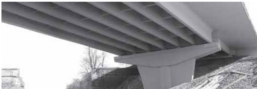
Рис. 7. Підсилення опори шляхопроводу добетонованими конусоподібними ребрами
