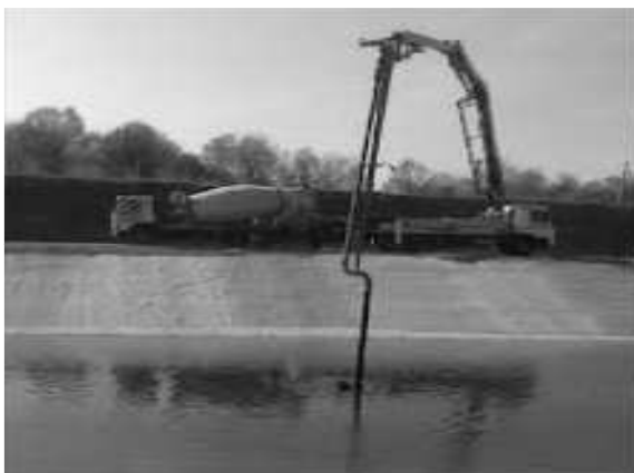
Рис.4 Підводне бетонування прямим подаванням бетонної суміші .
