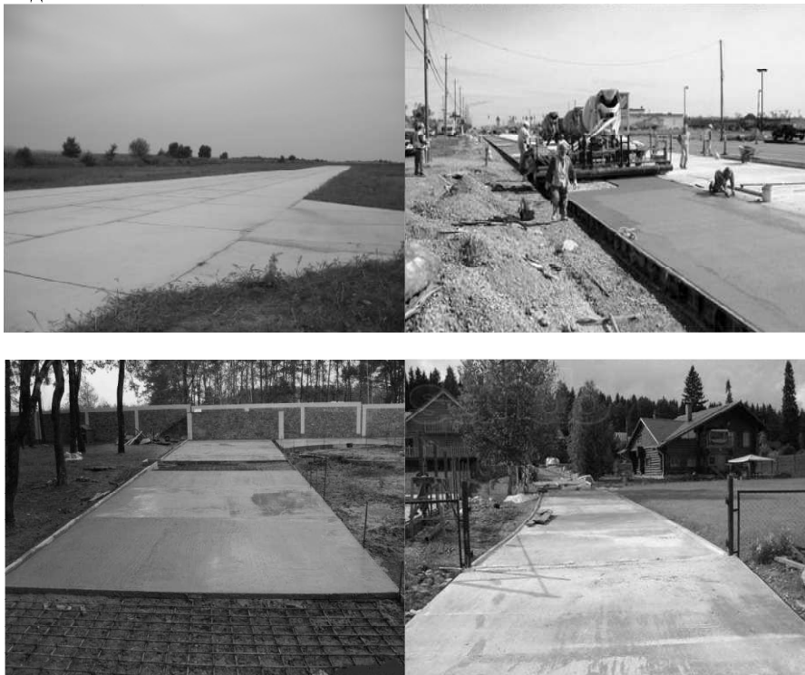
Рис.1. Примеры устройства жестких дорожных и аэродромных покрытий
